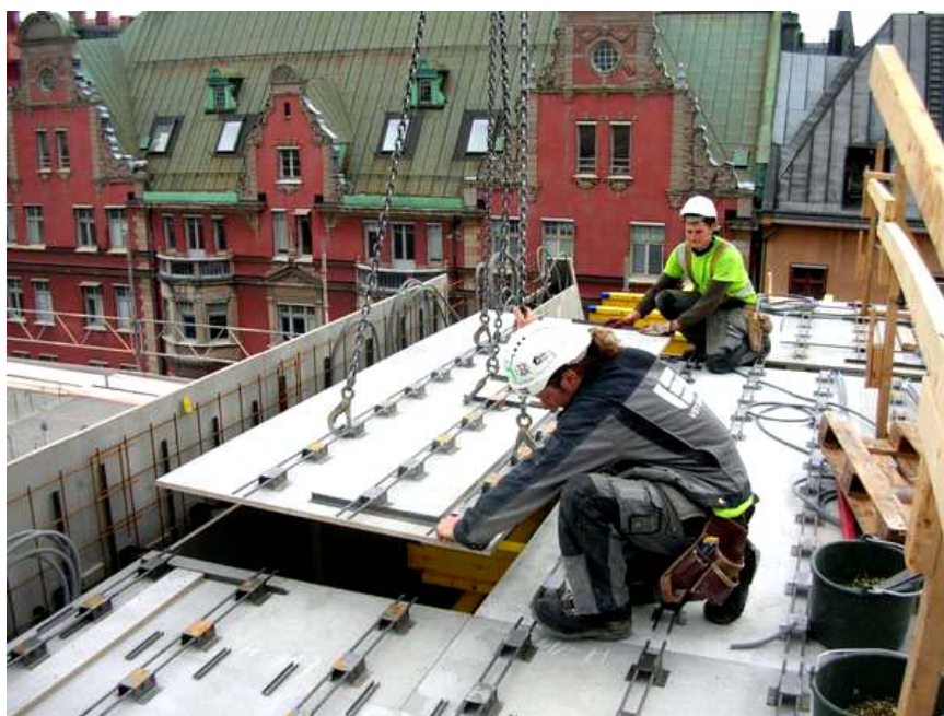
Рисунок 3. Монтаж плит перекрытий
