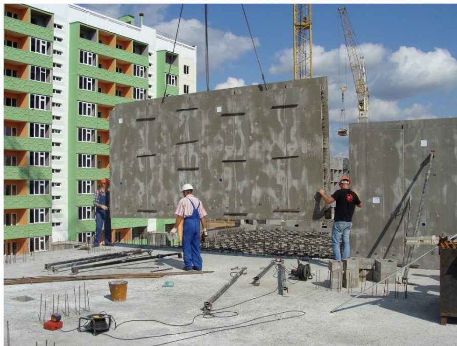
Рисунок 2. Монтаж стеновой панели
